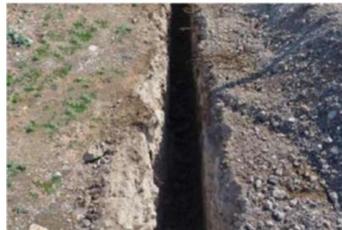
Figure 59 : Tranchées pour les gaines électriques
